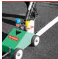
Traçage de lignes extérieures
